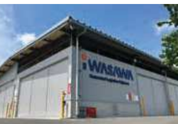
CLF高圧ガス 貯蔵施設
